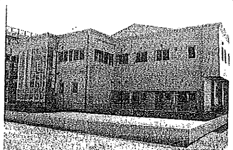
大麻生中学校屋内運動場建築工事
