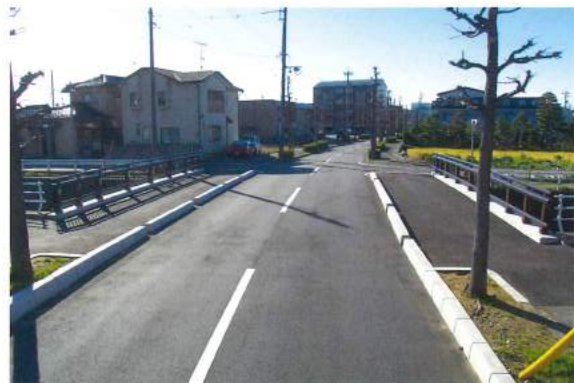
ジョイントレス構造施工例
