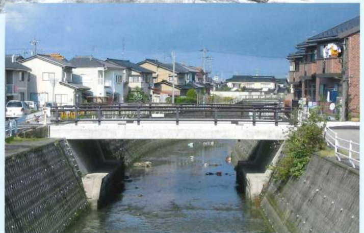
太郎田橋上部工架替工事 橋長13.10m 石川県金沢市(平成16年9月架)
